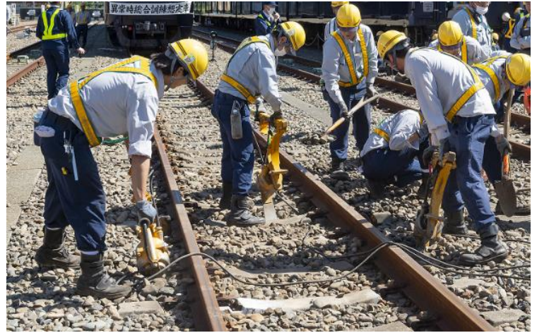
「異常時総合訓練（2023年度）」 損傷箇所の早期復旧訓練の様子
