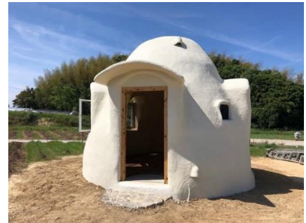
▲5月に完成したアースバッグハウス
