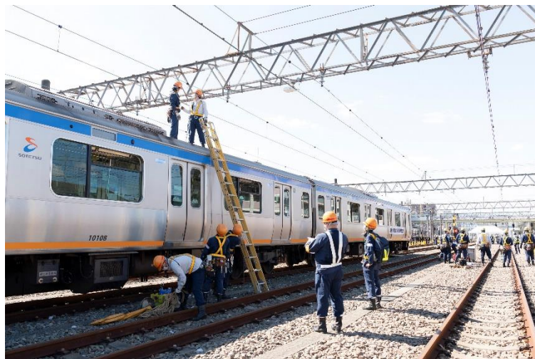
「異常時総合訓練（2021年度）」 損傷箇所の早期復旧訓練の様子
