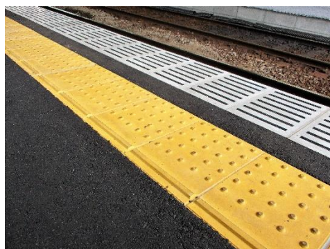
内方線付き点状ブロック設置
