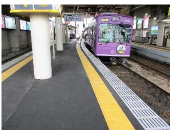
上)ホーム整備が完了した 帷子ノ辻駅
