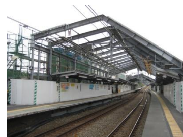
天王町駅改良工事の様子
