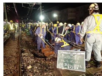
分岐器改良工事の様子
