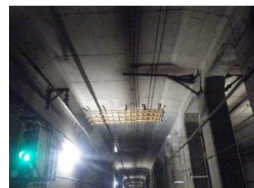
万騎が原トンネル内部の様子
