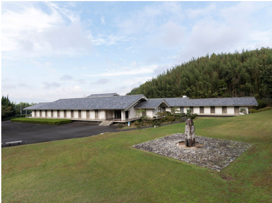
奈良文化財研究所 飛鳥資料館本館 全景
