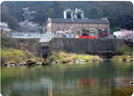
③大河原発電所
