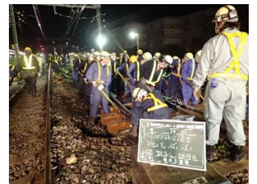
分岐器改良工事の様子
