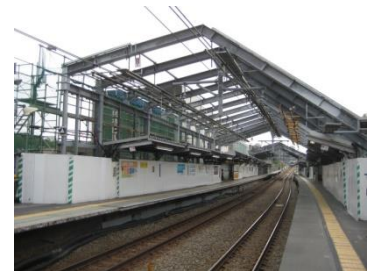
天王町駅改良工事の様子
