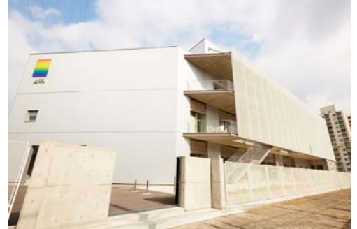
〈平成 26 年(2014 年)9 月完成〉 文芸学部D館 地上3階
