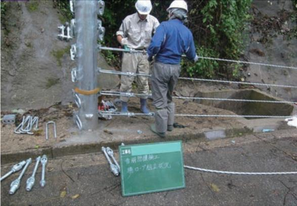
所定の位置にワイヤロープ、上辺ロープ、底辺ロープ、縦外辺ロープを取り付けます。必要に応じて間隔保持材を設置します。
