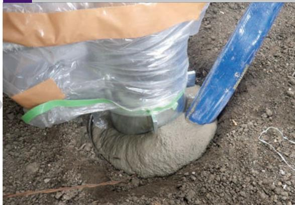
支柱の外周部分にモルタルを注入し、充填します。
