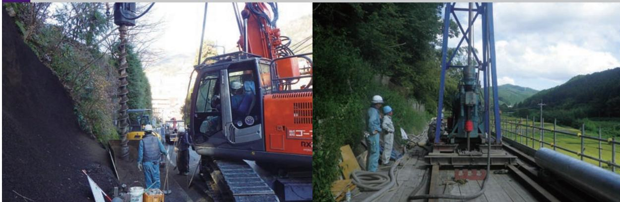
支柱建込み位置に、大口径ボーリングマシンを用いて削孔します。
