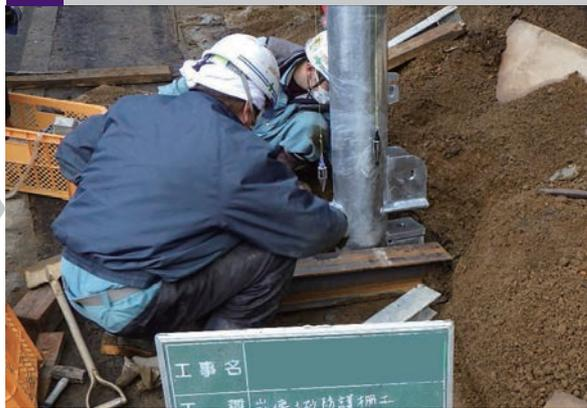
支柱の角度、高さ、間隔、ブラケットの向きを調整します。
