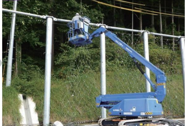
上辺ロープ、底辺ロープ、縦外辺ロープにシャックルでワイヤネットを取り付けます。ワイヤネットとワイヤロープの所定の交点位置に間隔保持クリップを取り付けます。
