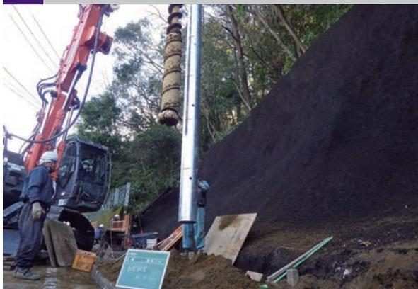
削孔した穴に支柱を建て込みます。
