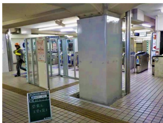
耐震補強工事(古川橋駅)
