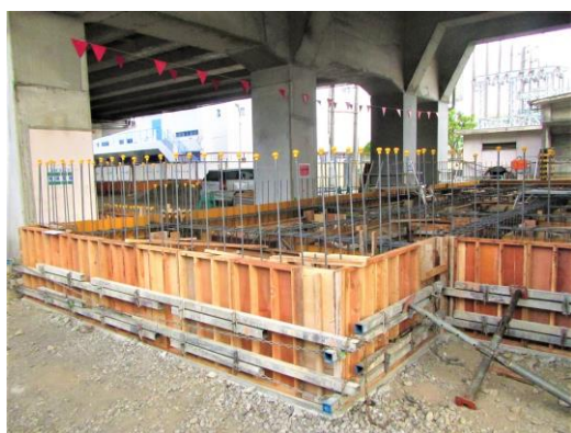
守口変電所更新工事
