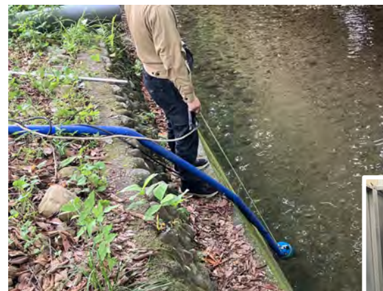
水中ポンプで河川から取水
