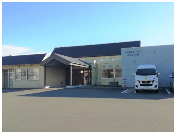
特別養護老人ホーム花ぶさ苑外観
