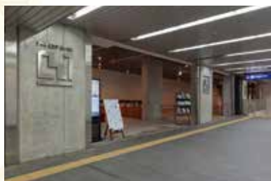
京阪電車 なにわ橋駅地下1階
