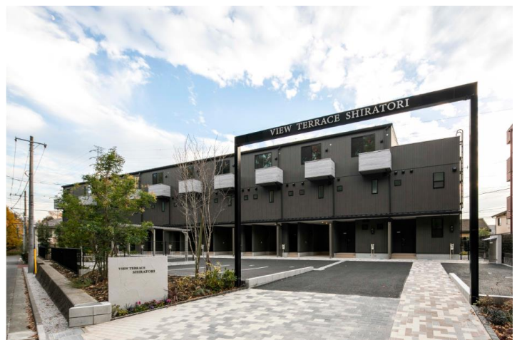
エントランス部分（北側）
