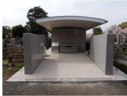
立体埋蔵施設（染井霊園） 使用許可日から起算して 20 年間は遺骨を地上のカロートに個別に埋蔵し、その後は地下に共同埋蔵します。
