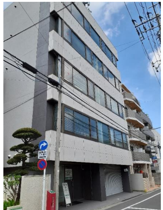
「都立大学駅前ビル」外観
