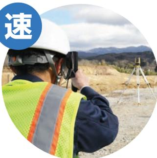
2. 杭打ちラインに入るとLN-100がプリズムを追尾し始めます。杭ナビVisionの誘導で素早く杭打ち点に移動できます。
